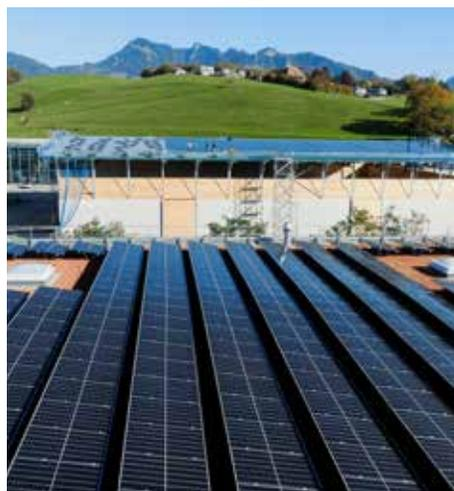
■ Die PV-Generatoren auf dem Flachdach und Trapezblechdach (im Hintergrund).
